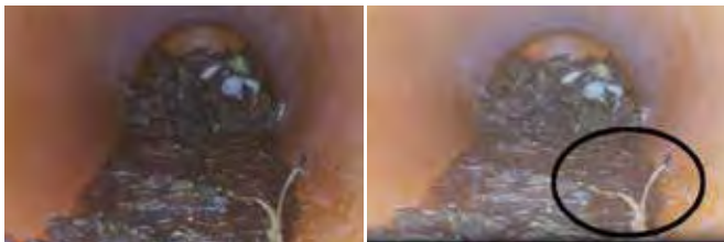
Imagen de una tubería durante la inspección.
