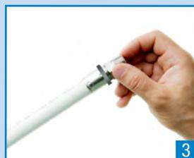
**3. Introduzca** el tubo en el accesorio sin utilizar lubricante (el accesorio viene lubricado de fábrica con silicona líquida).
