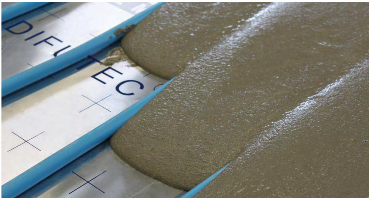
Sistema compuesto por el panel ALB-DIFUTEC® de 10 mm de espesor, la tubería multicapa ALB 17 x 2 mm y un recrecido de mortero ALB autonivelante de 1 cm de grosor por encima del tubo. **La altura total de esta solución es de tan sólo 3,70 cm** (pavimento final a parte), siendo óptima para la rehabilitación.
