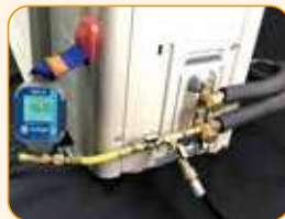
Vacío con vacuómetro VG64-LX
