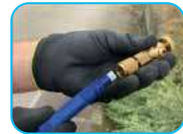
Colocación de nueva junta
